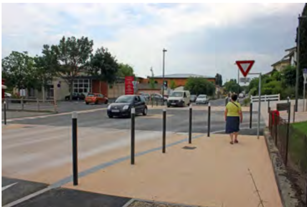
Exemple de travaux réalisés (revêtement, aménagement, ralentisseurs et création d'une zone 30)
